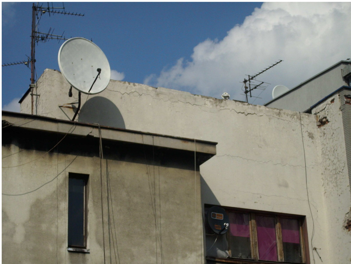
Zdjęcie nr 1 – Uszkodzenia muru wschodniego attyki – widok elewacji frontowej
