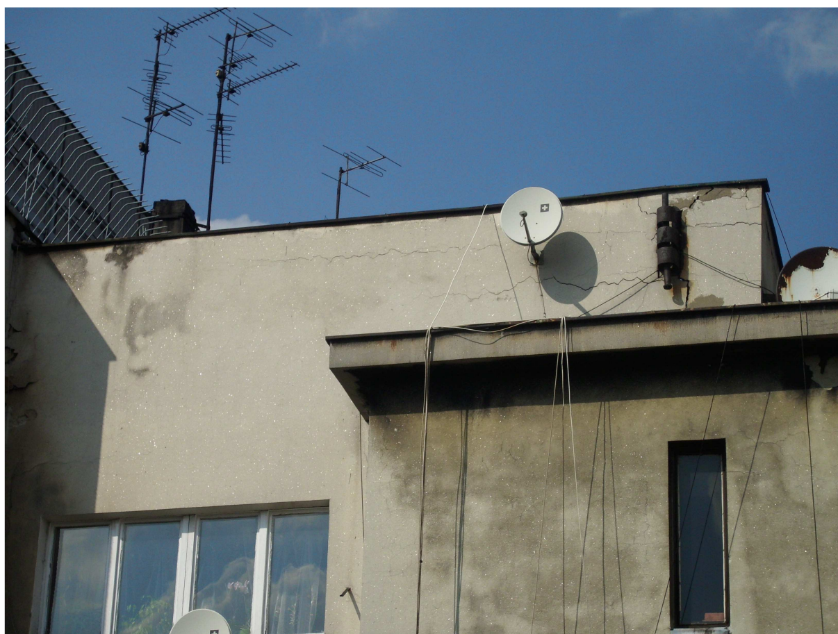
Zdjęcie nr 2 – Uszkodzenia muru zachodniego attyki – widok elewacji frontowej
