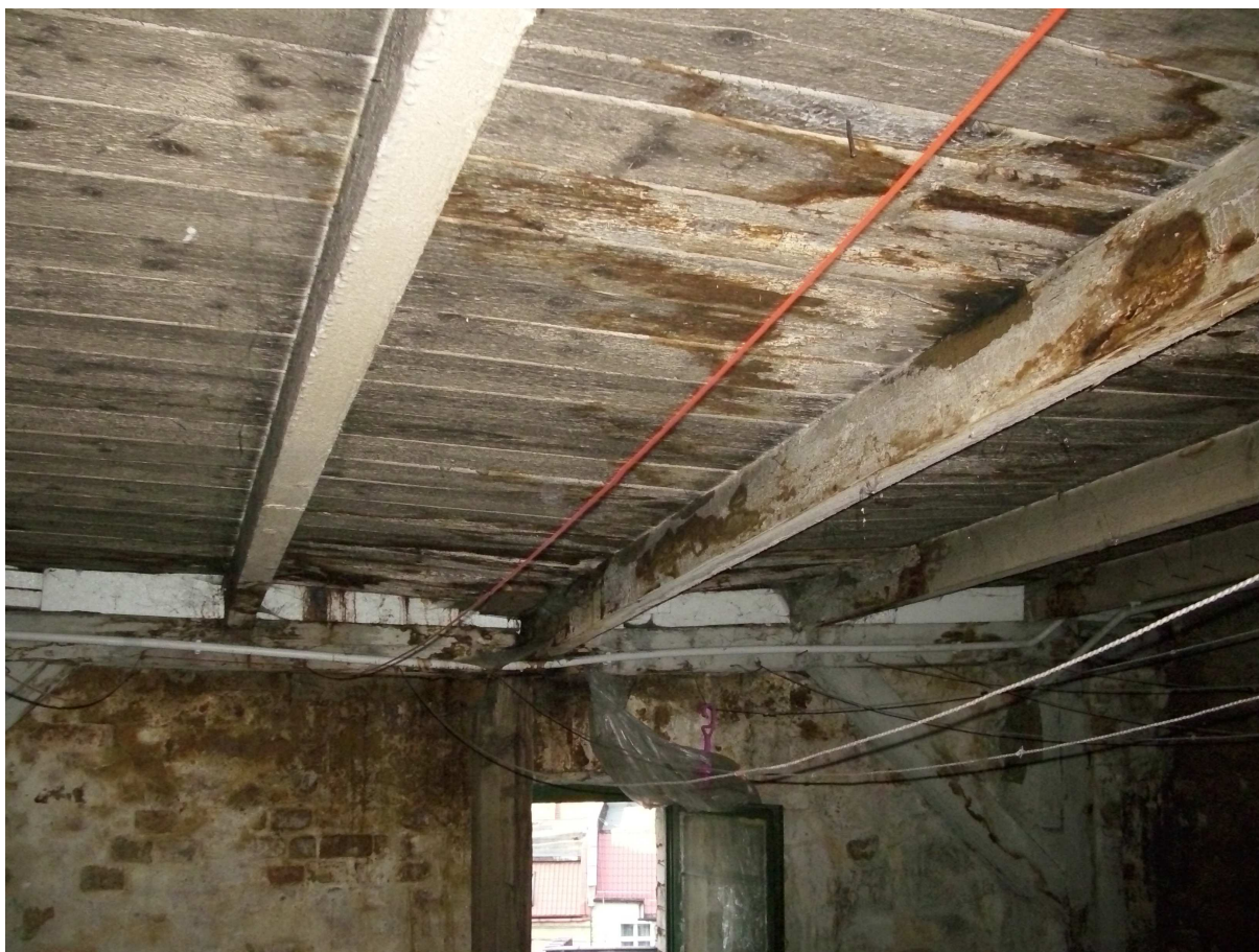
Zdjęcie nr 12 – Zapadlisko dachu, złamana płatew, przegnite krokwie na budynku frontowym
