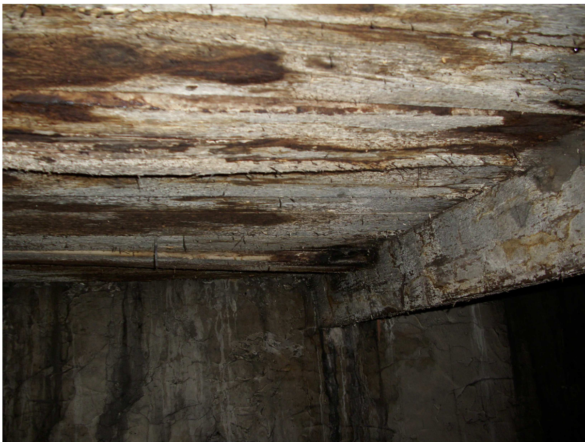
Zdjęcie nr 14 – Przekrój deskowanie w okolicy muru attyki na budynku frontowym
