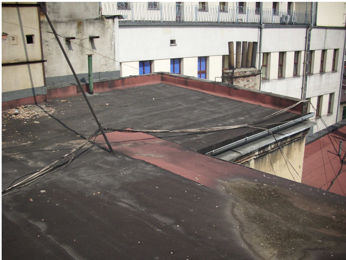
Zdjęcie nr 5 – Zapadlisko dachu na budynku frontowym
