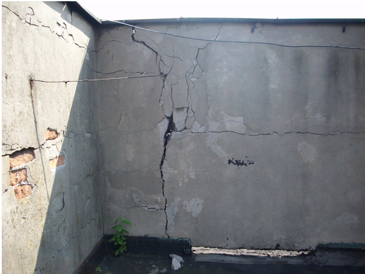
Zdjęcie nr 3 – Uszkodzenia muru zachodniego attyki – widok od strony dachu
