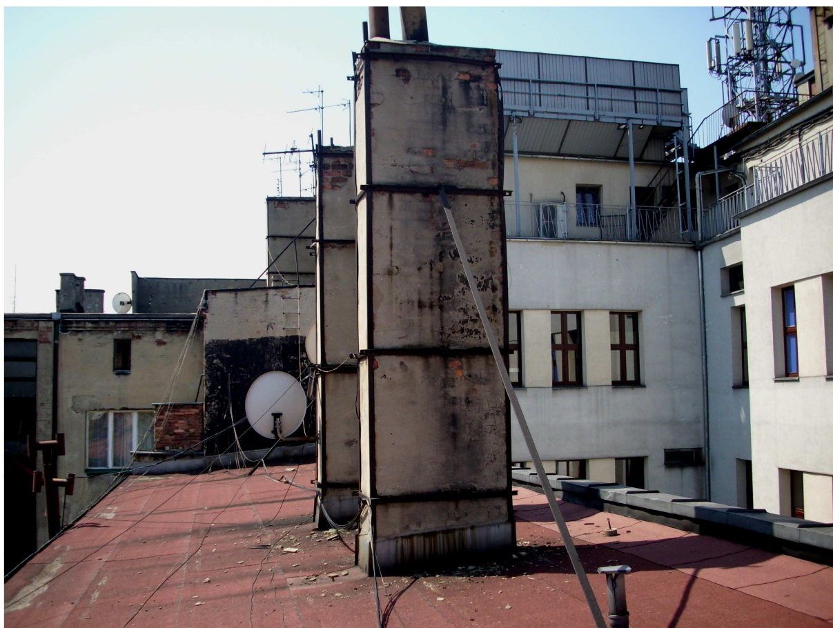
Zdjęcie nr 10 – Kominy wysokie na dachu budynku tylnego, zapadliska dachu
