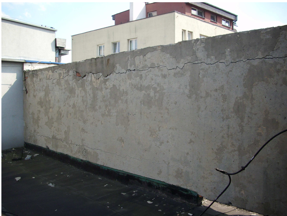
Zdjęcie nr 4 – Uszkodzenia muru wschodniego attyki – widok od strony dachu
